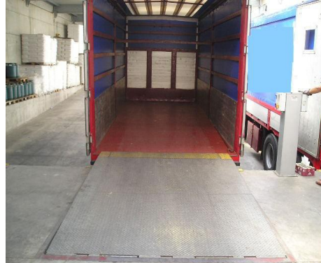
banchina di carico con rampa elettroidraulica
